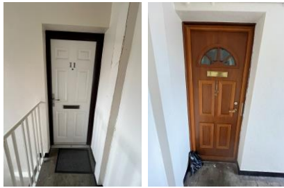
2 nd floor flats 11,12
