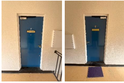
2 nd floor flats 5,6
