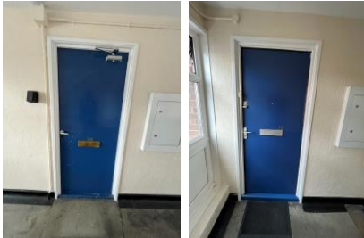
1 st floor flats 10,11
